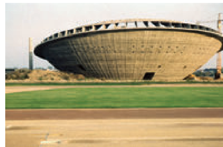
La salle de sport La Soucoupe en construction le 20 septembre 1964. Architectes : Vissuzaine, Longuet et Rivière. Photographie Henri Champy. Collection Henri Champy. Cliché Saint-Nazaire Agglomération Tourisme-Écomusée
