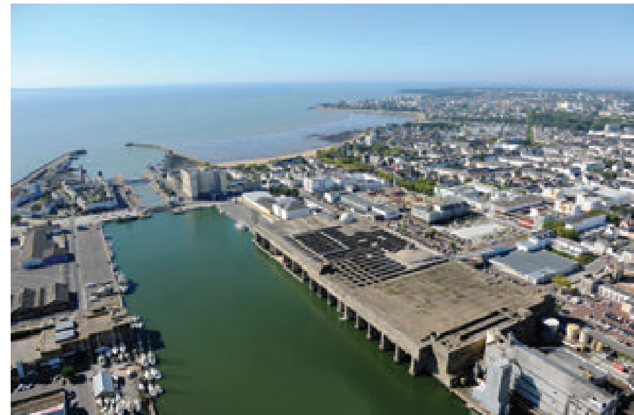
Le bassin du port et la base sous-marine de Saint-Nazaire. Vue aérienne, Photo Dominique Macel, Ville de Saint-Nazaire, 2010.
